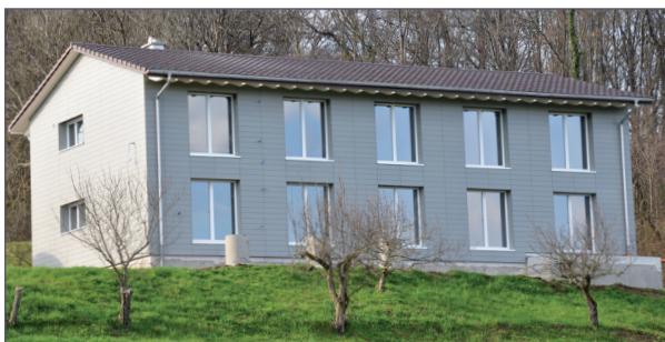
Einfamilienhaus in Auenstein Elementbau Fassade mit Eternit Wellplatten
