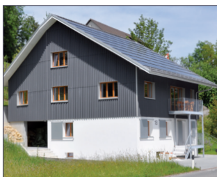
Einfamilienhaus in Auenstein Elementbau Fassade mit Eternit Wellplatten
