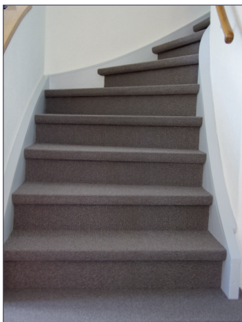
Felderboden Tanne mit Eichenfries Treppe neu belegt mit textilem Bodenbelag
