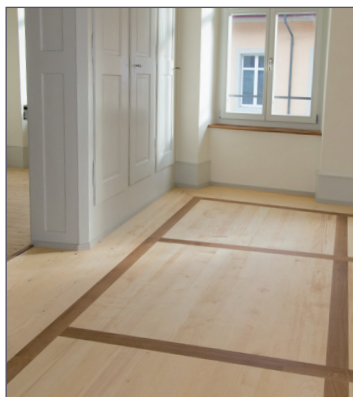
Felderboden Tanne mit Eichenfries Treppe neu belegt mit textilem Bodenbelag
